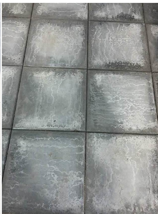
Afbeelding 2: Voorbeeld van secundaire kalkuitslag
