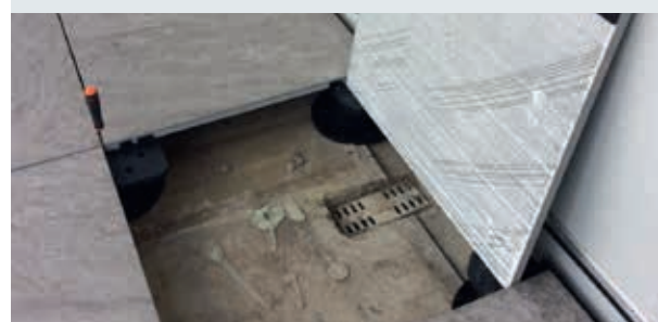
Na ontgrendeling is de ondergrond bereikbaar
