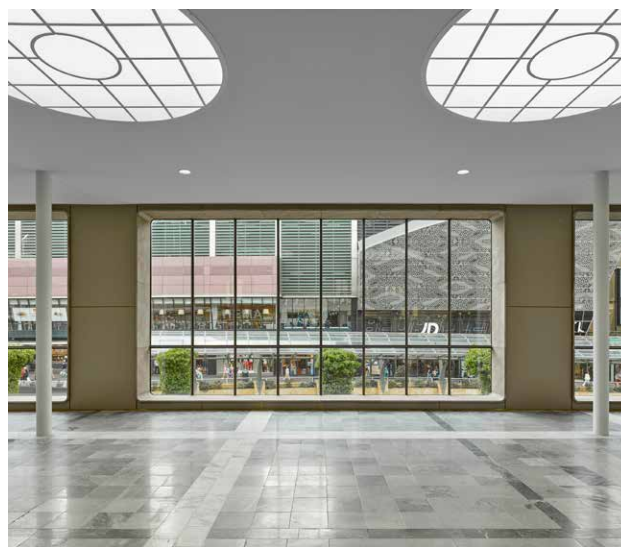
^ De dakramen zorgen voor extra daklicht in de onderliggende ruimte. (Foto: Joep Jacobs)
