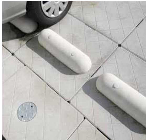
Plaats van een hemelwaterafvoer, uitgevoerd met een verlengde tegel
