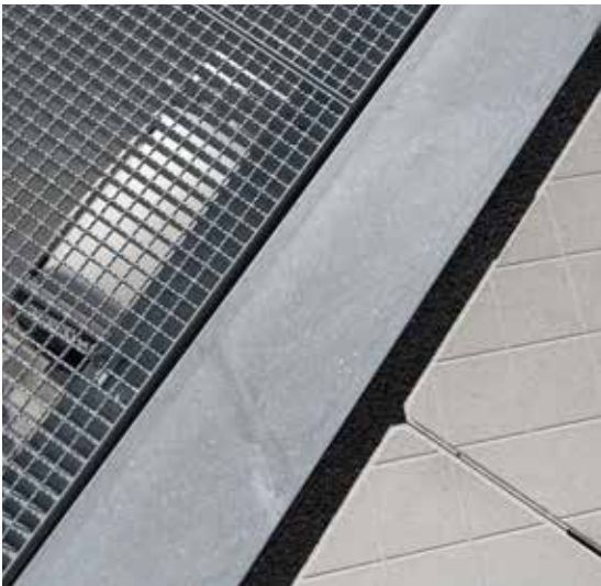
De aansluiting van de hellingbaan met het parkeerdak
