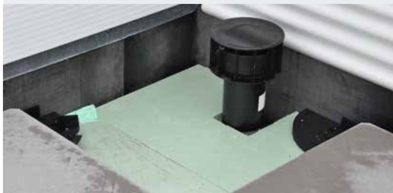
Aansluiting bij de borstwering met een sparing voor een ontluchting
