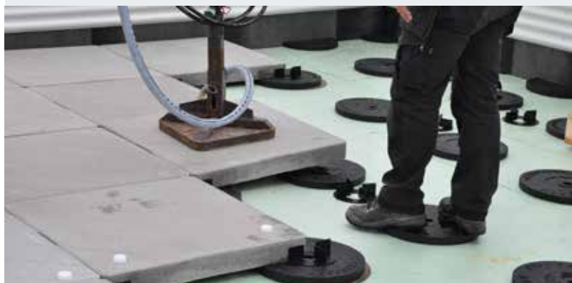
De tegels worden vacuüm verlegd
