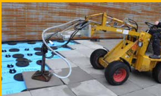
Het leggen van de tegels met een vacuümverlegger
