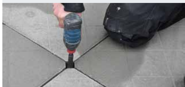
De tegels worden in twee fasen opgespannen door de stelschroef van het spanelement aan te draaien
